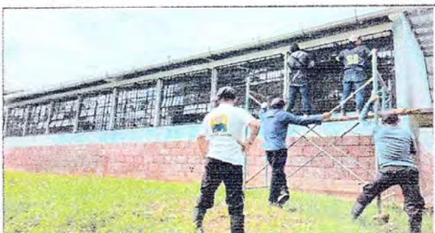
Foto 3: se procedió a colocar los balcones para cada uno de las ventanas que tiene la infraestructura de la escuela.
