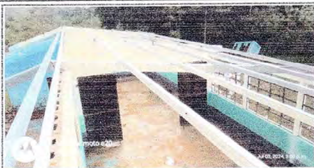
Foto 1: se procedió a sacar la infraestructura del techo del establecimiento para proceder a colocar los materiales adquiridos para dicho remozamiento.
