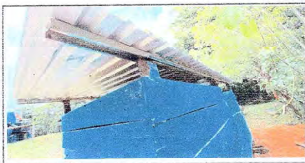
Foto 5: se procedió a colocar la estructura metálica nueva y el techo respectivo.
