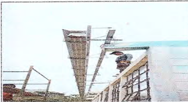
Foto 4: los canales para la bajada de agua, se procedió a colocarlos con su respectivo pescante.
